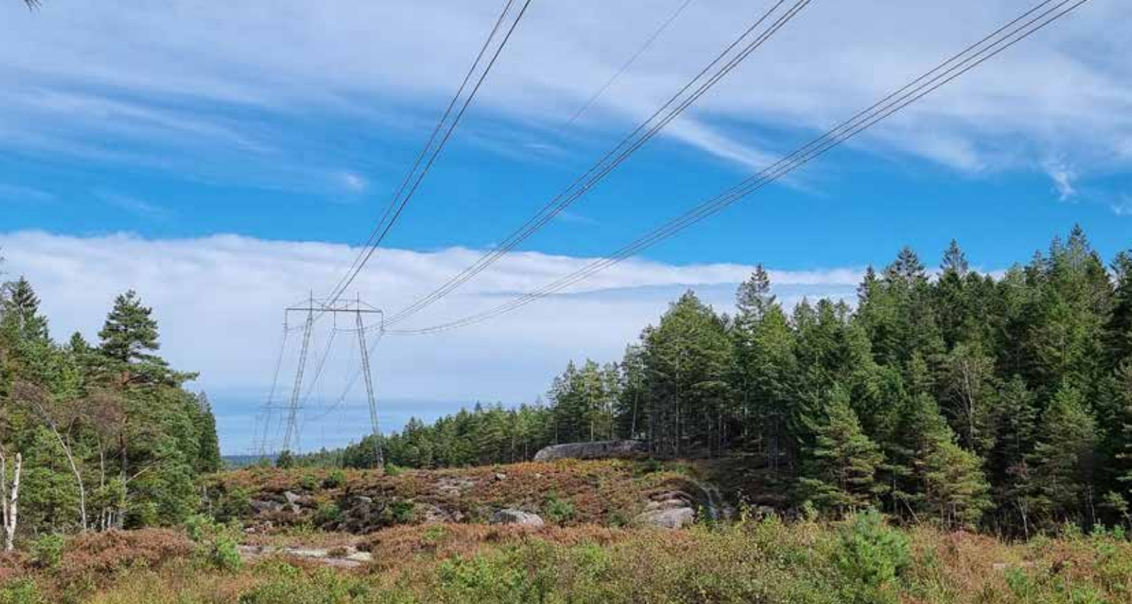
Figur 1. Kraftledningens nya sträckning låg huvudsakligen intill den befintliga ledningen. Foto mot sydväst längs ledningen öster om Benareby. Foto mot sydväst, Johanna Lega
