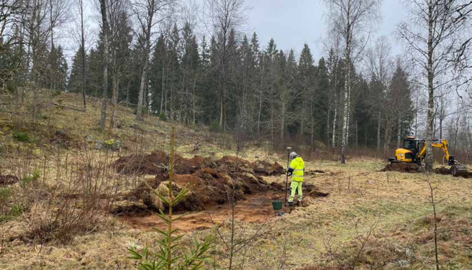
Figur 2. Schaktning och dokumentation i de sydvästra delarna inom boplatsområde L2024:1232. Foto Elinor Malmberg.
