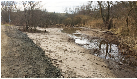
Arbetet med dammen för amfibier på väg att slutföras.
