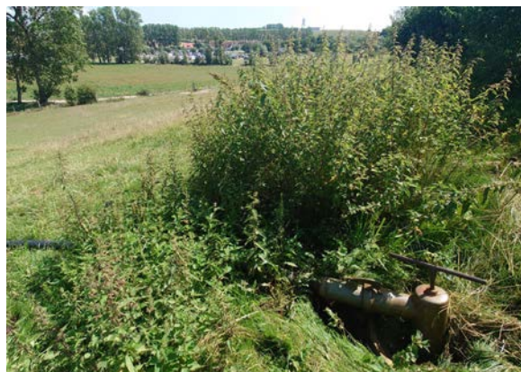
Brunn 13400518 (som är felaktigt inmätt på SGU:s karta) används för bevattning av jordbruk. Kapacitet 48 kbm/tim.
