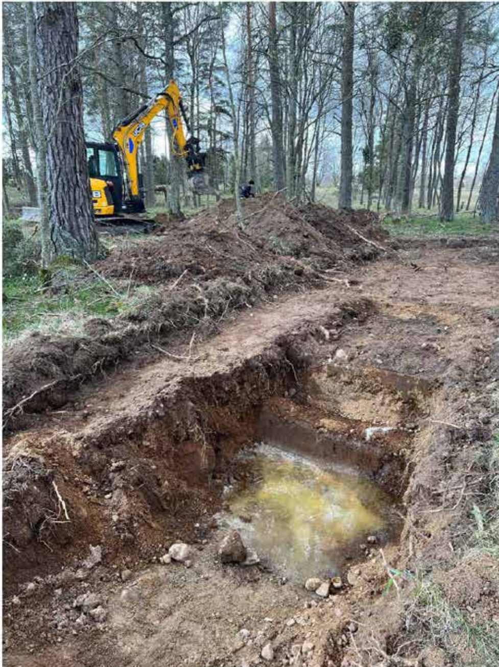
Figur 5. Provgrop NC1 – Blocklösa ytan. Vatten strömmar in från de sandiga materialen strax ovan moränen. Fri vattentyta mäts efter ca en halvtimme till omkring 0,6 meter under markytan.
