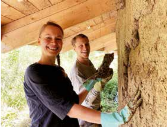
Så här kul är det att bygga med lera! Laura och Erik grovputsar utsidan på sitt hus.
