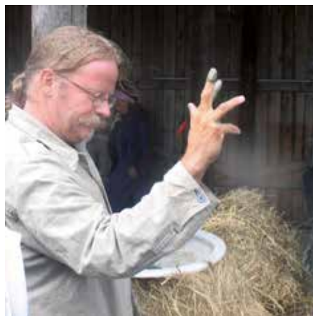
Michael demonstrerar konsistensen på lerslurry när lerhalm ska tillredas. Foto: Fred Andersson.
