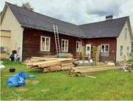
Under fasaden, bestående av ribbad masonit och tretexskivor, fanns rödmålad träpanel på det gamla filadelfiakapellet. Foto: Susanne Lindström.
