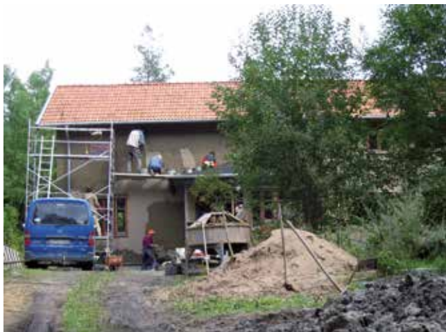
"Dugnad" vida Maja Malmgrens hus i Fjugesta - väggarna putsas med lera. (Foto: ER Lindberg)
