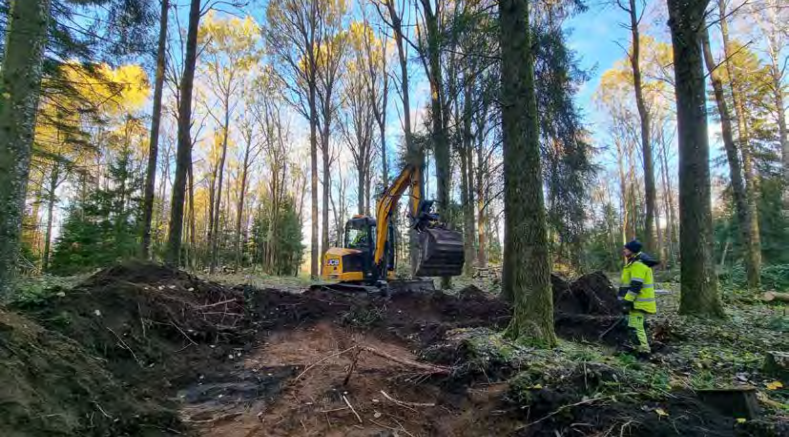
Figur 1. Pågående schaktning inom boplats L2021:6119. I schaktet syns en av de påträffade anläggningarna, härd A4154. Foto mot V. Johanna Lega.
