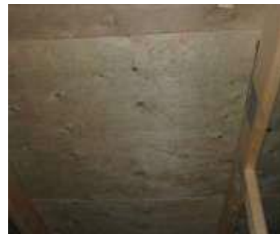
Bild 23 Mikrobiell påväxt på några år gamla underlagstak över välventilerade vindsutrymmen utan "felutförande". På råspontunderlagstaket kan i detta fall materialhanteringen före takläggning ha inverkat för uppkomsten av påväxt. (Foto: Anneling Tobin Consult AB)
