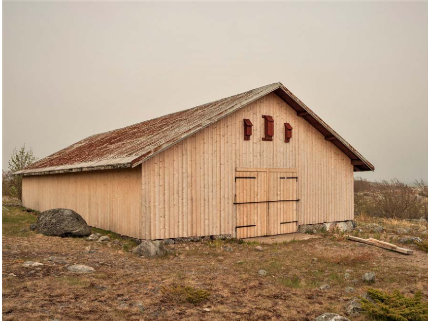
Figur 44. Byggnaden restaurerades så att det knappt fanns någon springa för fladdermössen att gömma sig i längre. Den 30 maj 2017 försågs byggnaden därför med fyra fladdermusholkar (tre av dem syns på bilden) som kompensation. FOTO: NICLAS FRITZÉN.
