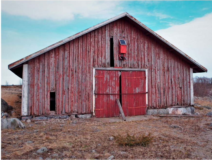
Figur 43. Denna byggnad på Norrskär var ett populärt tillhåll för trollpipistreller under höstmigrationen 2014. I den röda solpanelsförsedda lådan på väggen finns en fladdermusdetektor. FOTO (27 APRIL 2014): NICLAS FRITZÉN.
