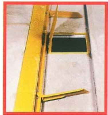
Gödselränna med nedsläpp. Hydrauliken ligger i en ingjutningslåda.
