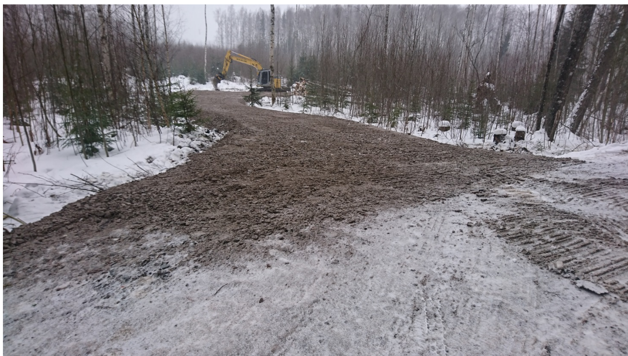
Kosteikkoalueen työmaalta helmikuulta 2018
